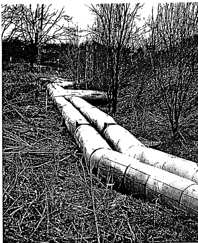
Fot. 1. Substandardowa infrastruktura energetyki ciepłej przebiegająca w rejonie osiedla Suchanino w Gdańsku
